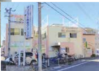
▼工事開始前のクリニック外観 (2020年2月時点)
